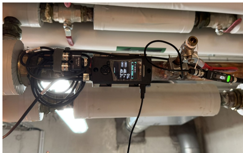
Pose sur tube nu, calorifuge déposé EHPAD Gétigné
