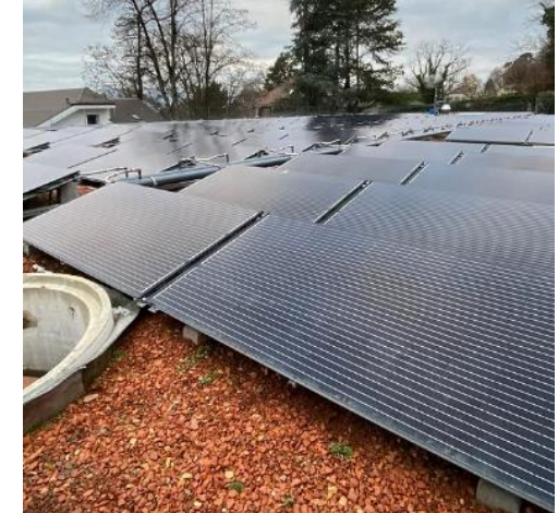
Capteur solaire thermique « simplifié » (moquette, PV-Thermique)
