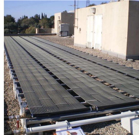
Capteur solaire thermique « simplifié » (moquette, PV-Thermique)
