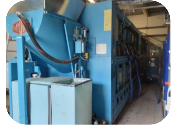
Tunnel de lavage
