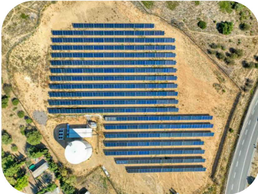
Réseau de chaleur de la ville de Narbonne (11) 3 232 \text{m}^2 de capteurs
