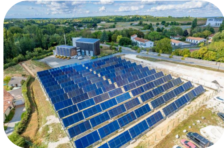
Réseau de chaleur de la ville de Pons (17) 1 800 \text{m}^2 de capteurs
