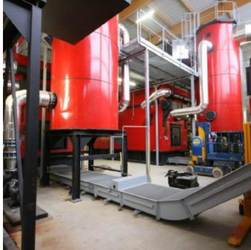
Figure 6 : Exemple d'évacuation des cendres par convoyeur à bandes (crédits : CIBE)
