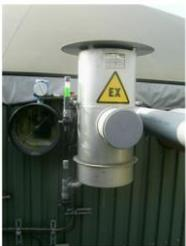
Exemple de soupape de sécurité.
